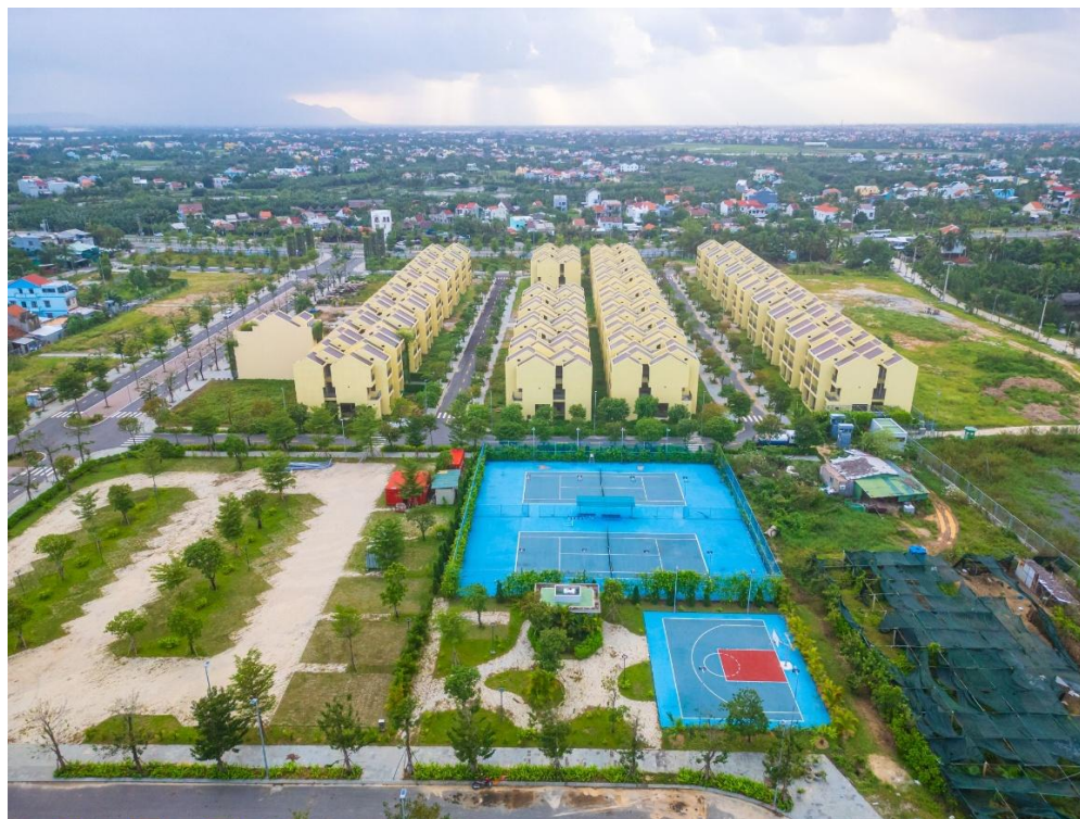
Hình 5: Tiến độ xây dựng T10/2025 tại Casamia Balanca
