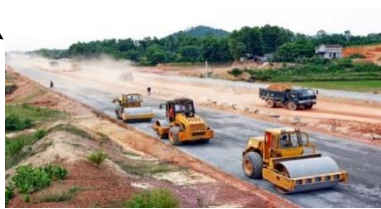
Thi công xây dựng
